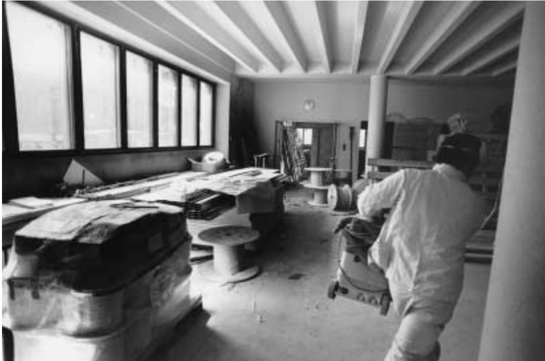
Die Umbauarbeiten laufen auf Hochtouren: Der Trakt entlang dem Petersgraben wird im Herbst einzugsbereit sein. (Foto: Peter Schnetz)
